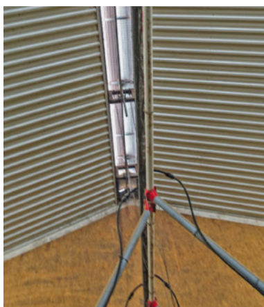
Das Lichtband am First ist beweglich und regelt die Lüftung.
